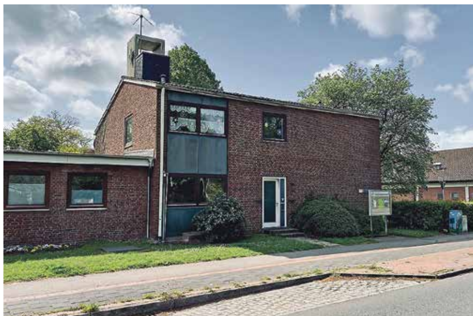
Hans-Böckler-Straße 40: Das zukünftige Gemeindehaus
