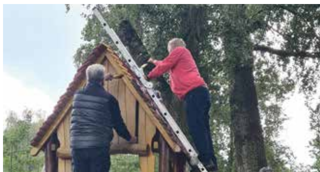
... und für einen neuen Anstrich der Spielgeräte gesorgt.
