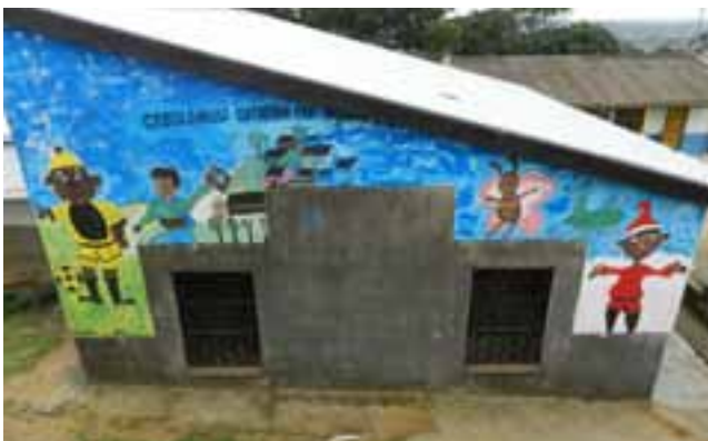
Das neue Dach des Kindergartens
